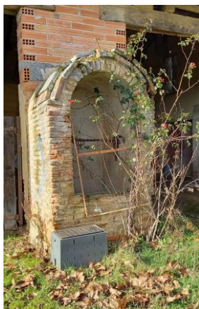
2 – Puits d'un ancien corps de ferme du village
