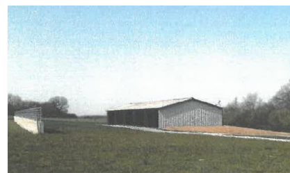
2 – Bâtiment à Gay
