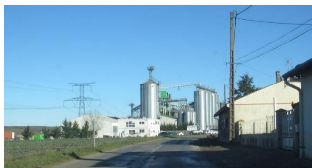
3/ Vue vers l'est sur les silos du Touch depuis la RD23
