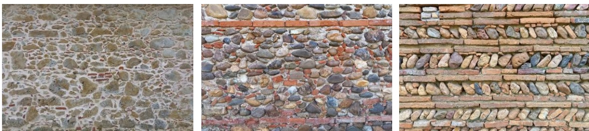
Figure 60 : Matériaux du bâti ancien du village
