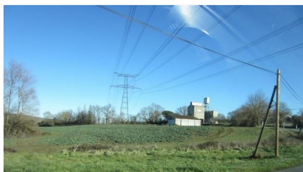
2/ Vue vers l'est sur le silo au niveau de l'embranchement des RD626b et RD23
