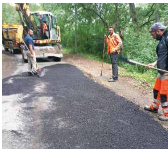
Renforcement de chaussée sur voie communale
